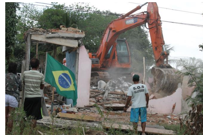
Demolição de uma das últimas casas da Vila autódromo no Rio de Janeiro Foto: Daniel de Andrade, meados de Maio de 2016
