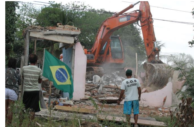
Abriss eines der letzten Häuser der Vila autodromo in Rio de Janeiro Foto: Daniel de Andrade, Mitte Mai 2016
