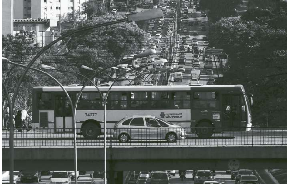
Viadukt über der Avenida Rubem Berta, in São Paulo
