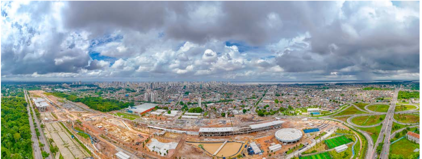
Baustelle des Stadtparks von Belém, in dem das COP30-Programm stattfinden wird (Foto v. 14.02.2025) Foto: Ricardo Stuckert / PR (CC BY-ND 2.0)
